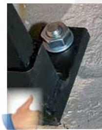
Utilisation d'une rondelle isolante pour limiter le couple galvanique
